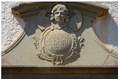
Hübscher Türsturz in der Rue des Remparts in Diemeringen
