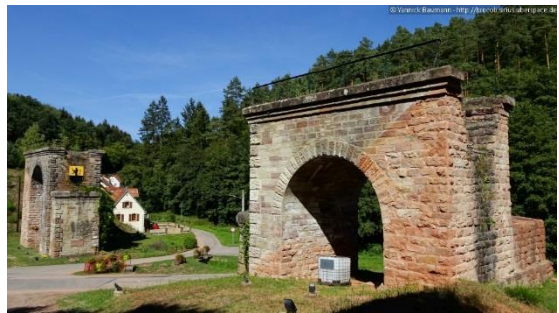
Ehemalige Bahnbrücke von Rosteig
