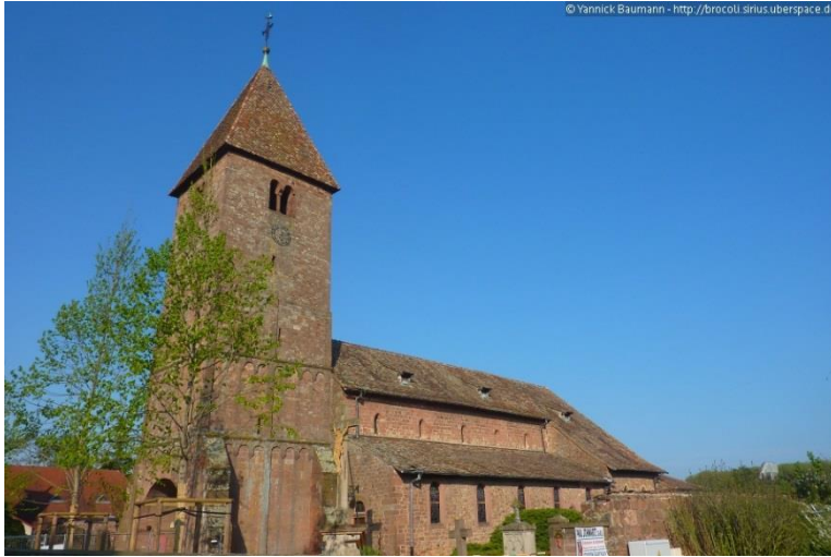
Kirche St-Ulrich in Altenstadt
