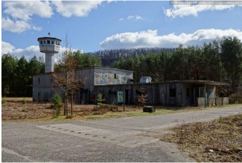
Area 1: Wachturm und Wachgebäude
