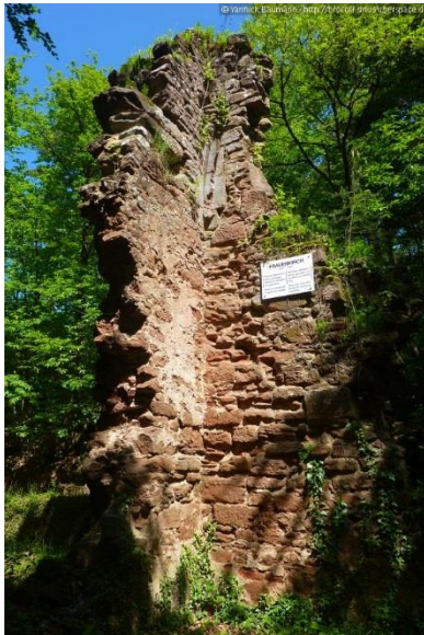
Reste des Treppenturms der Frauenkirch
